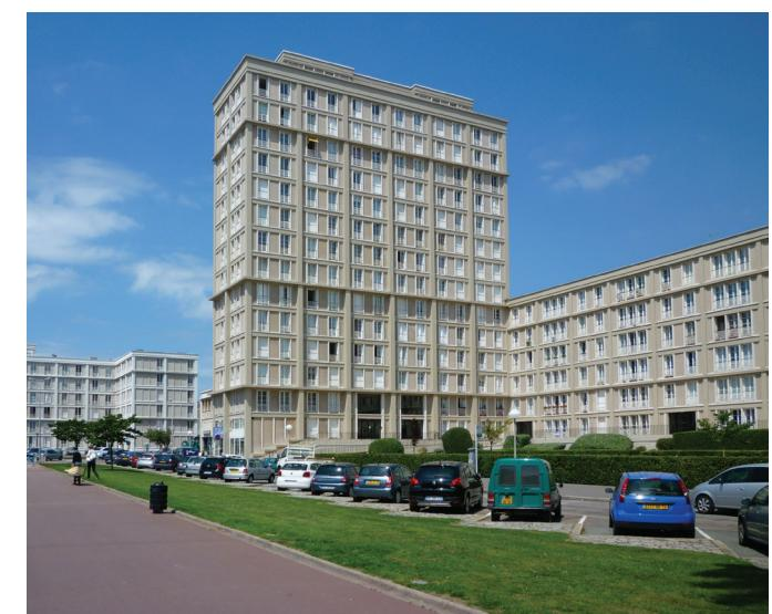
da Perret nella prima metà del Novecento, l'architettura immaginata per Le Havre assume l'ossatura in calcestruzzo armato come dispositivo costruttivo e figurativo. L'ossatura, esibita nelle facciate, è sottoposta a una ricerca espressiva che mira a individuare le parti e ordinarle sul piano-facciata secondo rapporti gerarchici.
