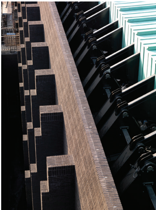
Dettaglio del muro di mattoni neri e dell'ingranaggio dell'ala del tetto apribile / Detail of the black brick wall and the mechanism of the retractable roof's wing
